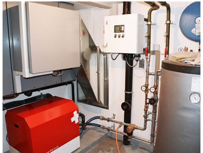
Innengerät AWS-I mit Pufferspeicher. (Hydraulik 2.0)
